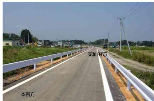
写真-2 アスファルト舗装完了後の専用道
