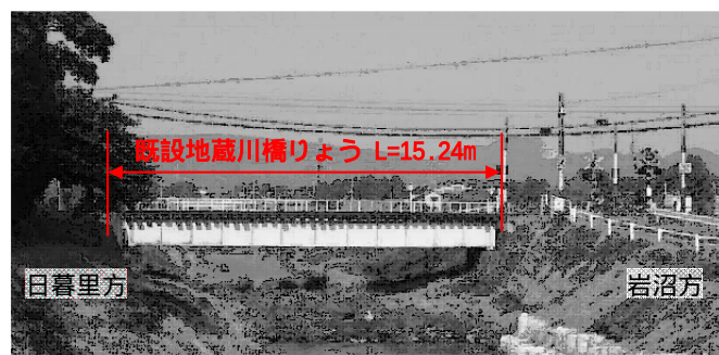
写真 - 1 現在の橋りょう
