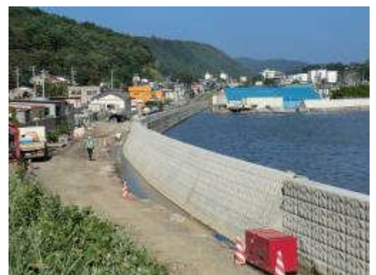
写真－3 重力式護岸（施工後）
