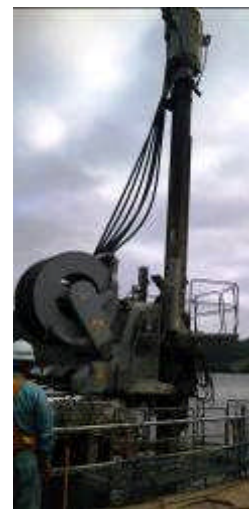
写真－2 クラッシュパイラー
