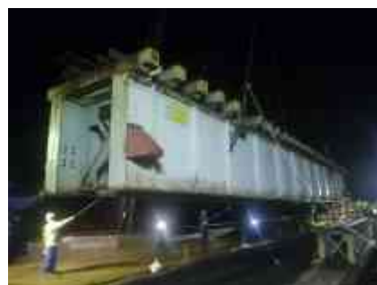
図 - 5 桁撤去時の状況
