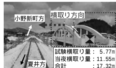
図 2 新設橋りょうの写真
