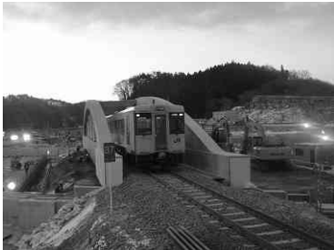
図 7 横取り架設完了写真
