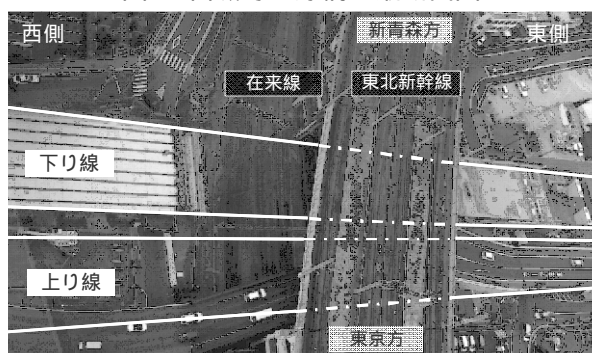
図-2 施工中の現地写真
