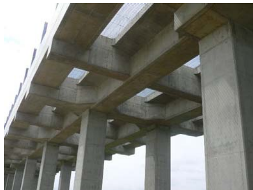
写真－1 開床式高架橋の施工例 （北海道新幹線の新線区間）
