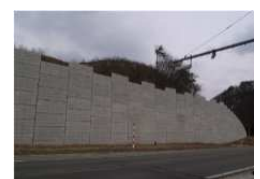
写真-2 震災後の補強土壁
