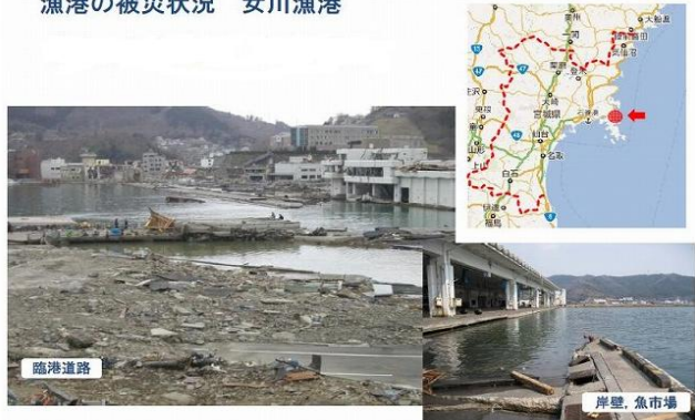
写真 2 女川漁港（被害状況）
