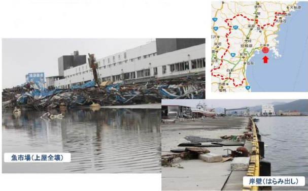
写真 1 石巻漁港（被害状況）
