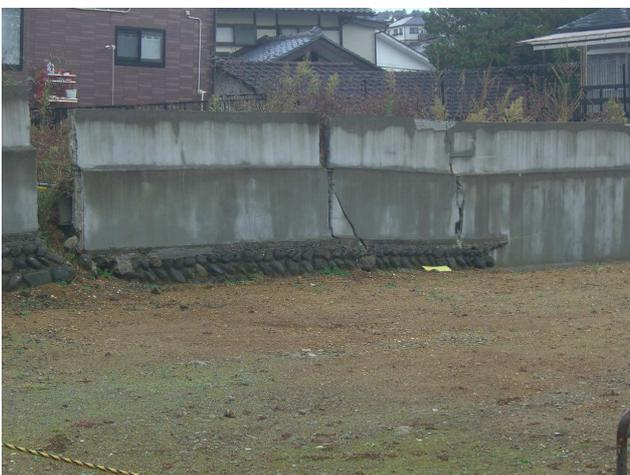
写真 1 コンクリート擁壁の倒壊
