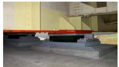
写真2-ジャッキダウン後、支取取替完了
