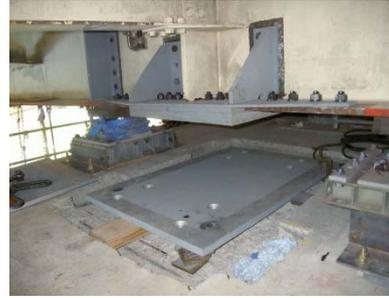
写真1-下フランジ 拡幅・アンカーボルト・ベースプレート
