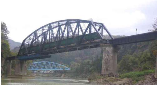
写真-2 架設桁の設置状況
