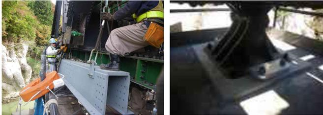
写真-3 損傷箇所への復旧状況
