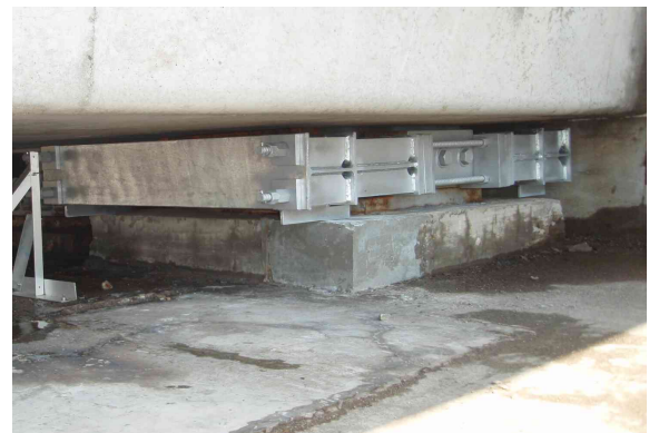
写真－5 鋼製移動制限装置設置状況
