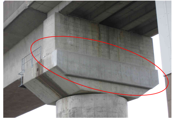
写真－4 パラペット背面のコンクリート補修後
