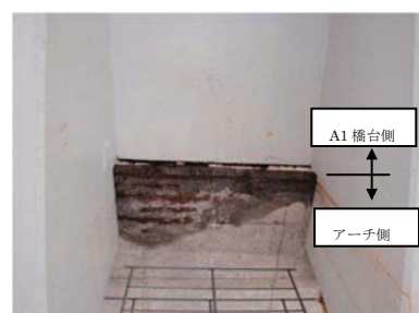
写真-1 P1 桁端部床版下面
