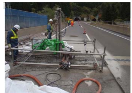
写真-3 桁端部鉛直部はつり状況
