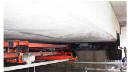
写真-2 桁端部床版下面はつり状況
