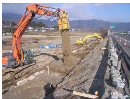
写真-3 施工状況、変位観測杭
