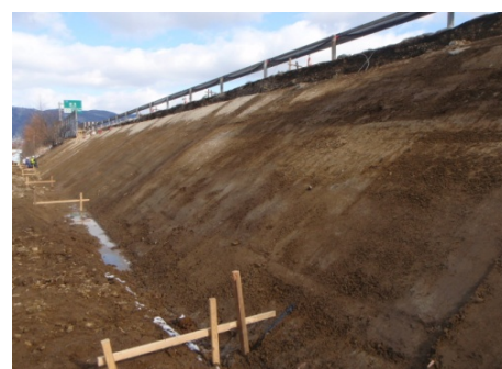
写真-4 完成のり面
