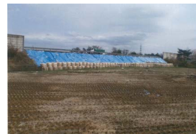
写真-2 応急復旧全景
