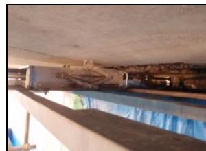
写真-3 狭隘部用ウォータージェット装置
