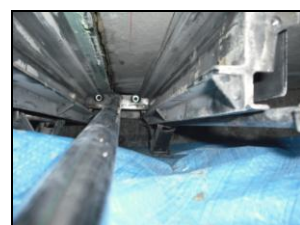
写真-5 フレーム押込み機による陽極の設置
