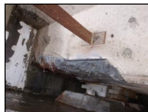
写真-2 施工前の桁端狭隘部状況
