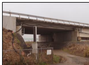
写真-1 対象橋梁全景
