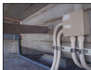
写真-6 施工後の桁端狭隘部状況
