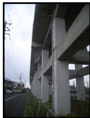
写真1 新幹線橋りょう例
