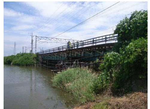
写真-1 測定対象橋りょう
