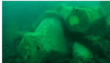
図8 釜石港湾口防波堤(開口部) 港内側
