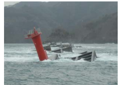
図1 釜石港湾口防波堤（北堤） 現地状況写真
