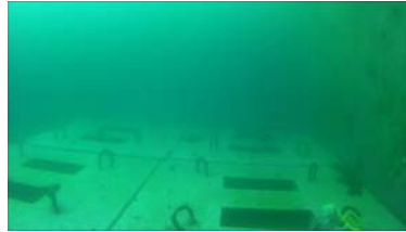
図7 釜石港湾口防波堤(北堤)浅部 港外側
