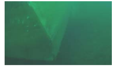
図6 釜石港湾口防波堤(南堤)深部 開口部側堤頭函 港内側
