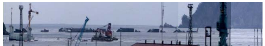
図11 釜石港湾口防波堤被災進行状況写真 (第3波引き波時の防波堤の状況)
