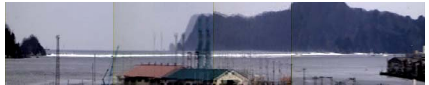
図9 釜石港湾口防波堤被災進行状況写真 (第1波来襲時の防波堤の状況)
