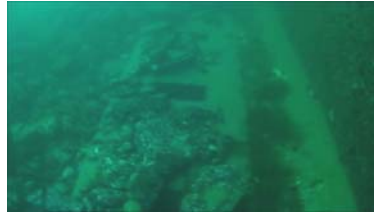
図5 釜石港湾口防波堤(南堤)深部 港内側
