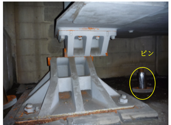
写真-2 左側固定側支承
