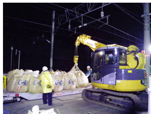
Photo.2 MCへの資機材積込
