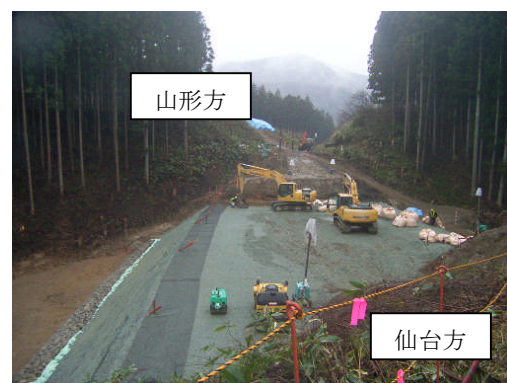
Photo.3 碎石による盛土施工状況
