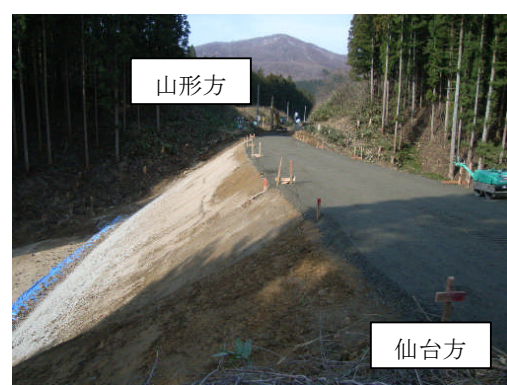
Photo.4 盛土構築完了時
