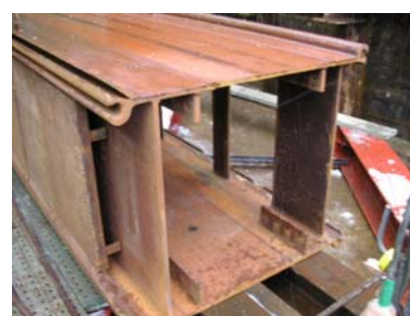
写真-1 連結部断面
