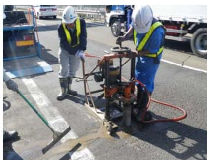
写真-8 路面の削孔状況
