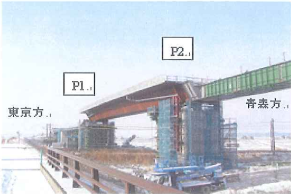
② 桁送出し完了（平成23年1月14日）
