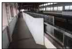
図5 仮囲い設置状況
