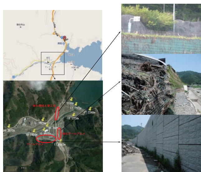
図-4 釜石市両石地区の補強土壁
