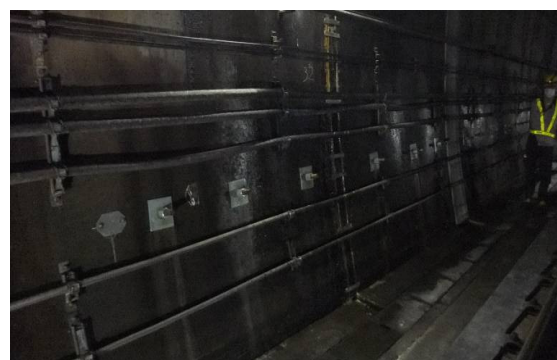
Photo.5 側壁部のロックボルト打設後の状況
