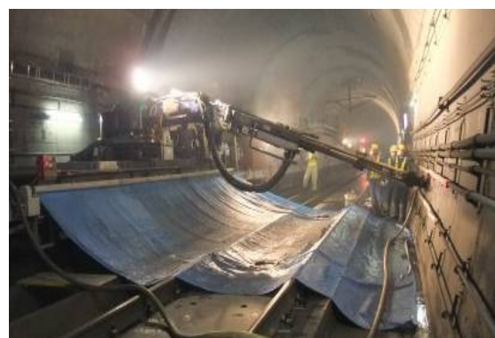
Photo.4 保守用車でのロックボルト打設の状況
