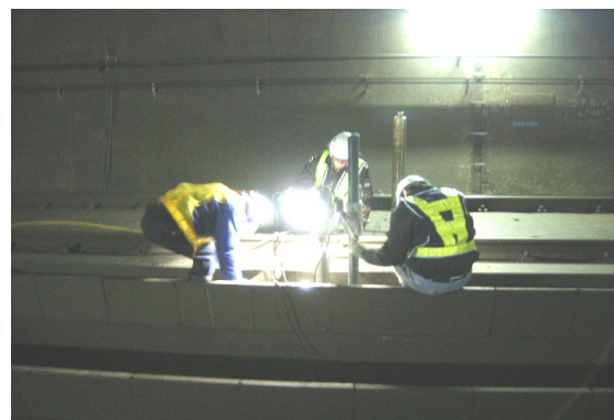
Photo.3 コア削孔の状況
