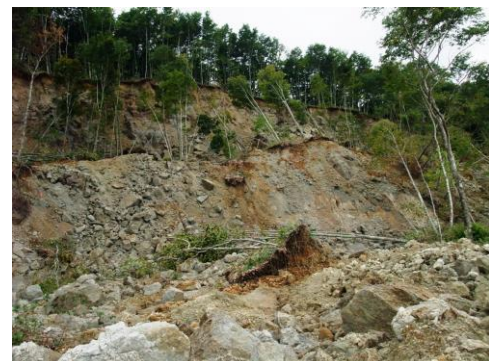
写真-2 冷沢崩壊で見られるスランプ型崩壊
