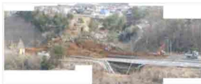
写真-1 あさひ台団地の造成盛土の崩壊状況
