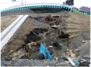
写真-4 B-2 現場状況
