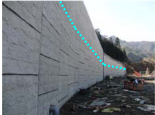
写真-3 B-1 現場状況
