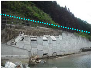
写真-1 A-1 現場状況
