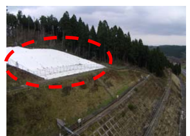
写真－5 頭部排土及び 地下水排除対策工
