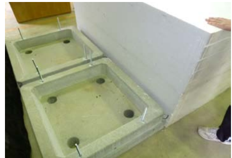
写真 1 設置作業状況
