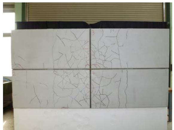
写真 5 硬式野球ボール速い球 100 球終了後のクラック発生状況
