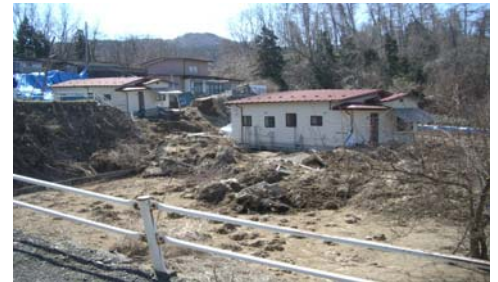
写真 1 崩壊現場の状況
