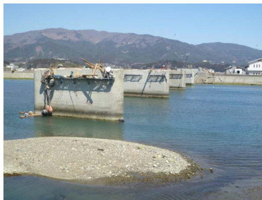
写真-1 気仙大橋の全景
