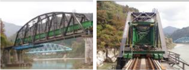
写真-2 架設桁の設置状況
