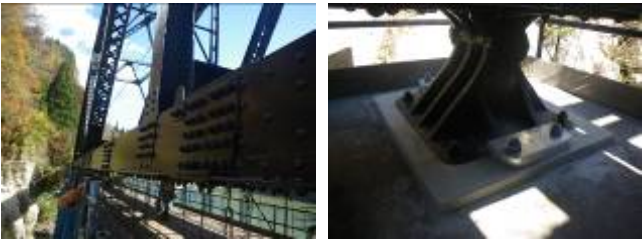
写真-3 損傷箇所の復旧状況
