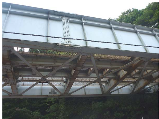
図-4 塗装桁状況（第一角館架道橋）
