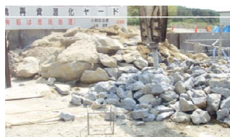
写真1 コンクリートの小割状況
