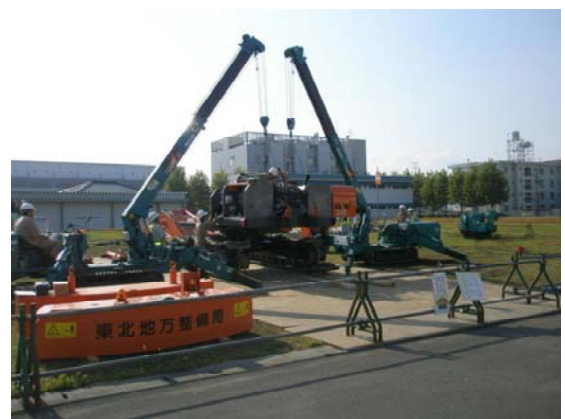
写真-4 ミニクローラークレーン2台相吊りによる組立状況（エンジンフレーム）
