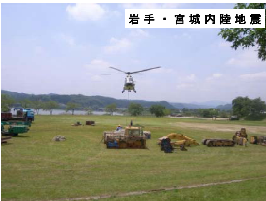
写真-1 油圧ショベル0.5m3級の空輸の状況
