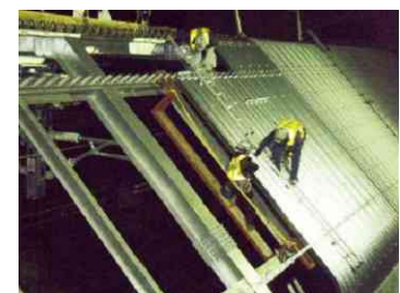
写真-4 屋根材設置状況
