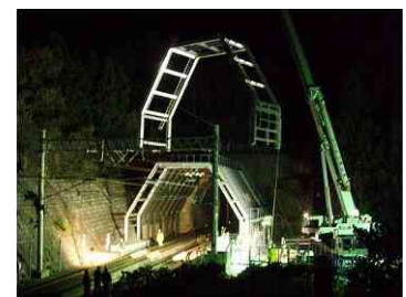
写真-3 主構設置状況
