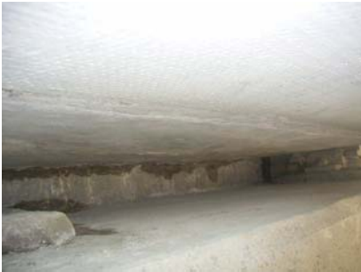
写真-7 完成状況
