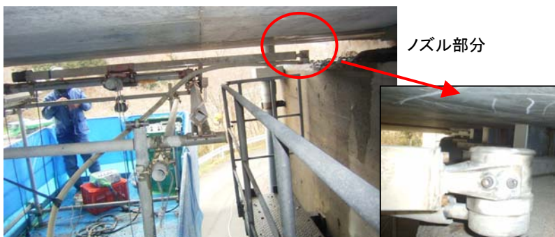
写真-2 WJ機械設置状況(高所作業車)
