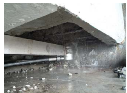
写真-3 はつり処理後の状況
