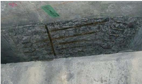
写真-5 はつり処理後の状況
