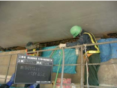
写真-6 断面修復材吹き付け状況
