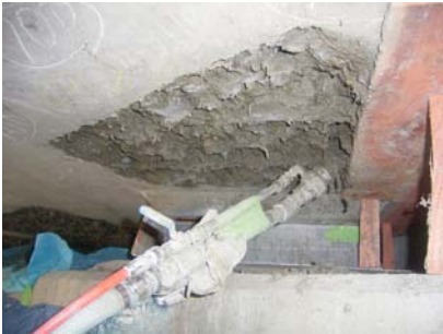
写真-6 断面修復材吹き付け状況
