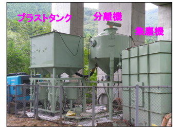
写真-5 プラスト機・集塵機
