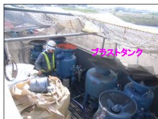
写真-8 プラスト機材設置状況
