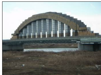
写真-6 アーチ部吊足場
