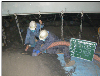
写真-1 足場内回収状況
