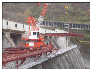
写真－1 レール据付状況
