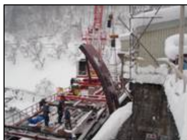
写真－4 扉体据付状況
