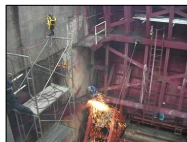
写真－2 脚柱撤去状況
