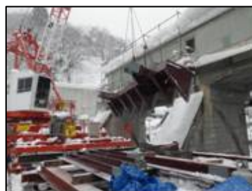
写真－3 主桁据付状況
