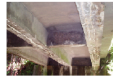
写真-1 信夫橋の床版(水原福島線) 写真-2 橋の床版を支える桁の損傷状況
