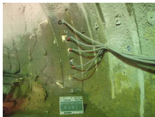
写真-3 坑内真空揚水状況
