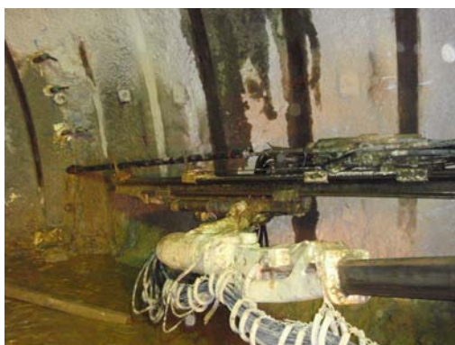
写真-2 長尺ウェルポイント施工状況
