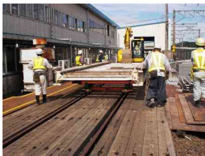
写真-1 工事桁運搬
