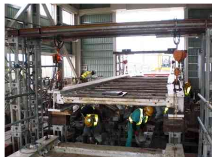
写真-2 工事桁架設
