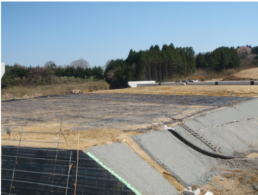
写真 3.敷網工の施工状況
