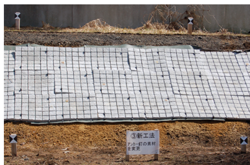
写真-1 現地計測現場
