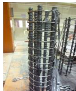
写真-2 内部鉄筋
