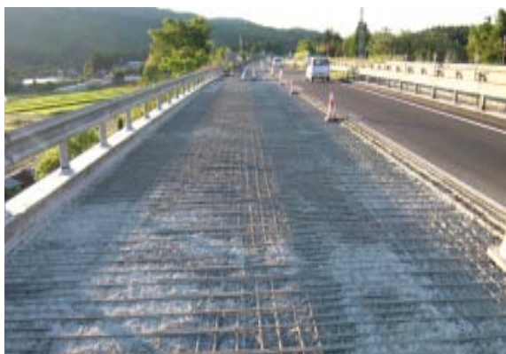
写真-1 RC 床版損傷箇所はつり取り状況
