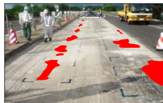
写真-2 浮き損傷 (赤着色部)
